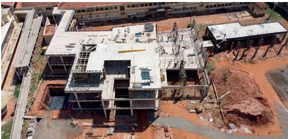
A obra de ampliação do Hospital Emílio Carlos entra em nova fase. Após a conclusão das alvenarias e da estrutura de concreto dos dois pavimentos dos setores A e B, os principais do projeto, que interligam esse novo anexo ao prédio atual, os trabalhos se concentram no setor C, que comportará, nos seus dois pavimentos, 30 boxes de serviços, consultórios, salas para pequenos procedimentos, vestiários, sanitários, recepções e salas de espera, entre outras.
