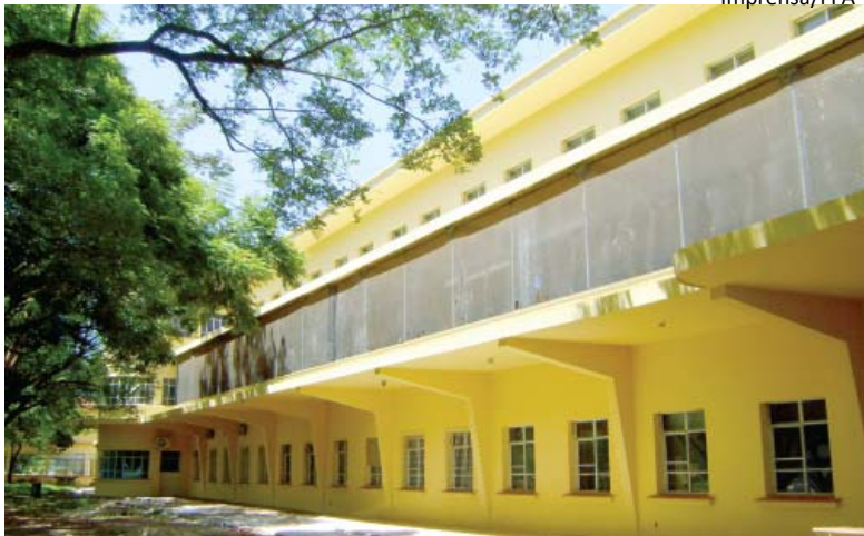
RECUPERAÇÃO Mais um trecho do prédio do Hospital Escola Emílio Carlos foi recuperado. Os trabalhos continuam. Página 12.
