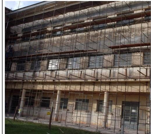
**RECUPERAÇÃO** A Fundação Padre Albino está recuperando a fachada externa lateral direita do Hospital Emílio Carlos, incluindo estrutura de concreto armado e pintura das paredes e esquadrias metálicas. No local estão os setores de Psiquiatria, C2 Par Masculino e Ambulatório de Ginecologia. O término da obra está previsto para 100 dias.
