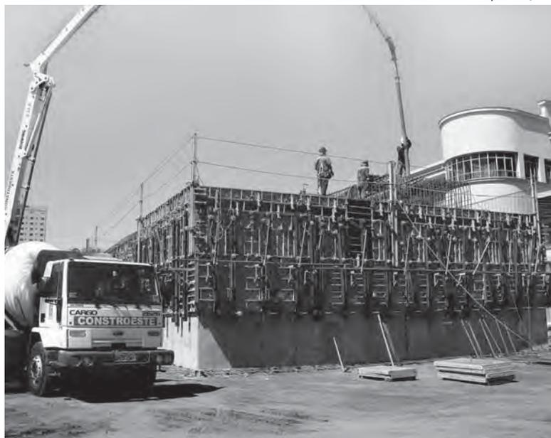
A RPA Construtora e Incorporadora Ltda, responsável pela execução das obras do Serviço de Radioterapia da Fundação Padre Albino, começou no dia 12 de setembro a concretagem da laje das casas matas.
