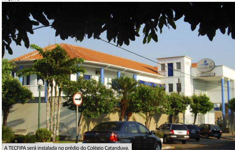
A TECFIPA será instalada no prédio do Colégio Catanduva.
