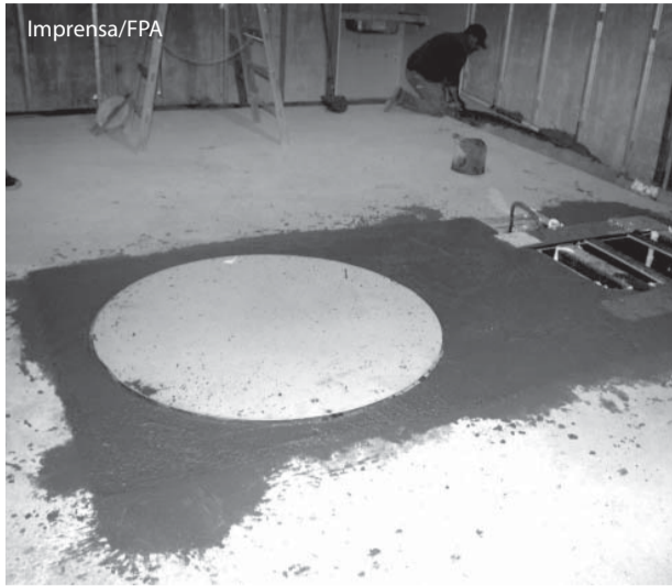
A base do acelerador concretada.
