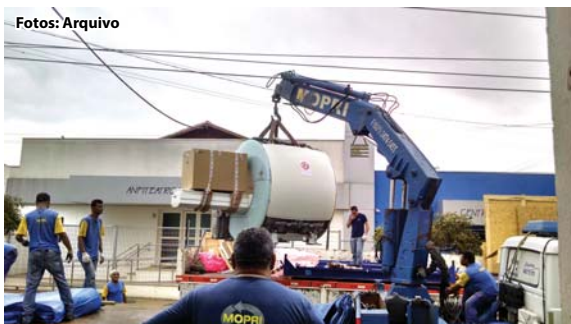
Retirada do aparelho do caminhão.
