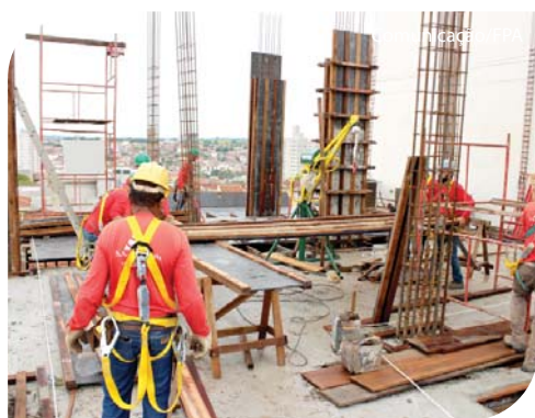
Obras fazem parte da primeira etapa do projeto de reforma e ampliação.
