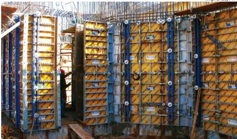
A RPA, construtora responsável pela execução das obras do Serviço de Radioterapia, terminou a concretagem da estrutura de concreto armado das paredes das casas matas. O trabalho agora será concretar a laje, cujo término está previsto para três semanas.
