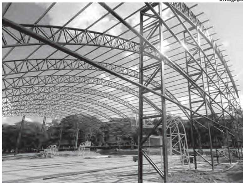
**QUADRAS** No fechamento desta edição, a empresa responsável executava o terçamento das quadras poliesportivas do Câmpus Sede das FIPA, que é a colocação das barras de ferro onde as telhas de aço serão parafusadas (foto). As próximas etapas são o projeto elétrico e pintura do piso com as novas demarcações exigidas.
