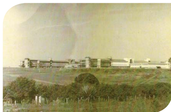
Hospital Emílio Carlos em construção.
