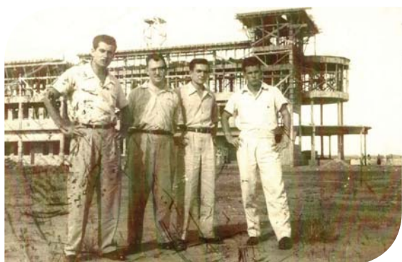
Início das obras do Hospital Emílio Carlos.
