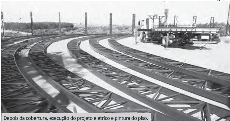
Depois da cobertura, execução do projeto elétrico e pintura do piso.
