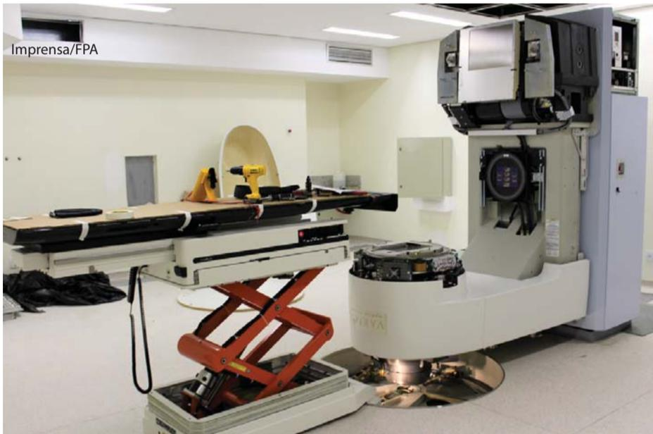
O engenheiro da Varian Medical Systems Inc. está em Catanduva desde o último dia 26 de novembro para realização dos ajustes, montagem dos componentes, execução das conexões de operação e calibragem do acelerador linear do Serviço de Radioterapia/HCC. Enquanto isso, as obras externas avançam. **Página 11.**
